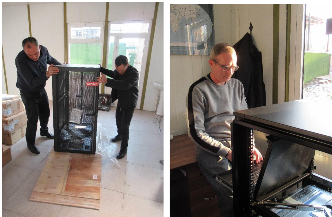
Рис. 1. Работы по установке СНП.
